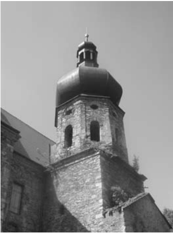
Der renovierte Turm
