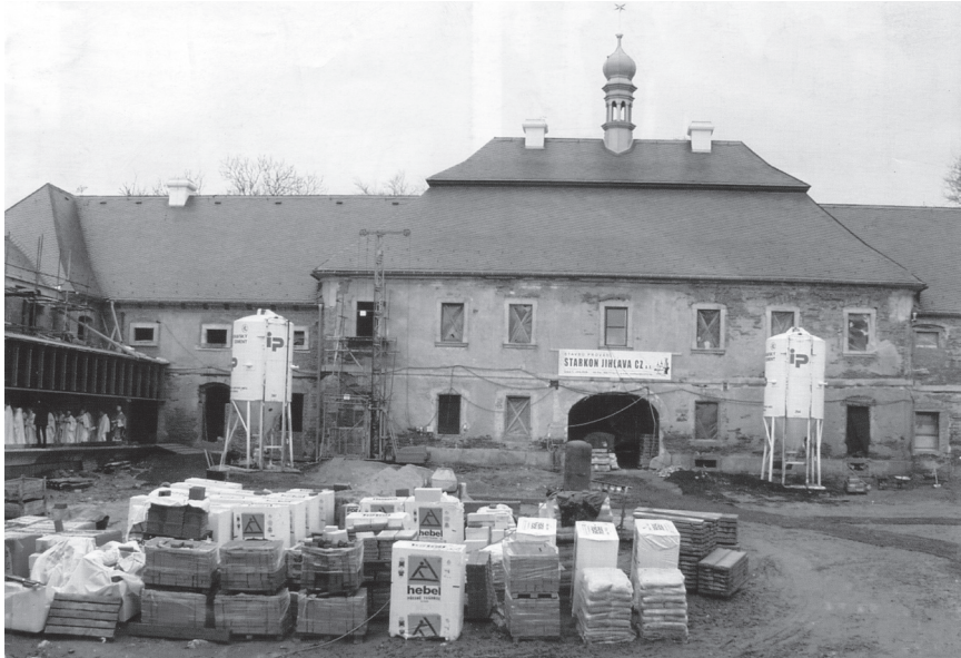
Das barocke Hauptgebäude des Klosters
